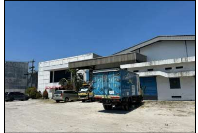
Tampak depan Pabrik
